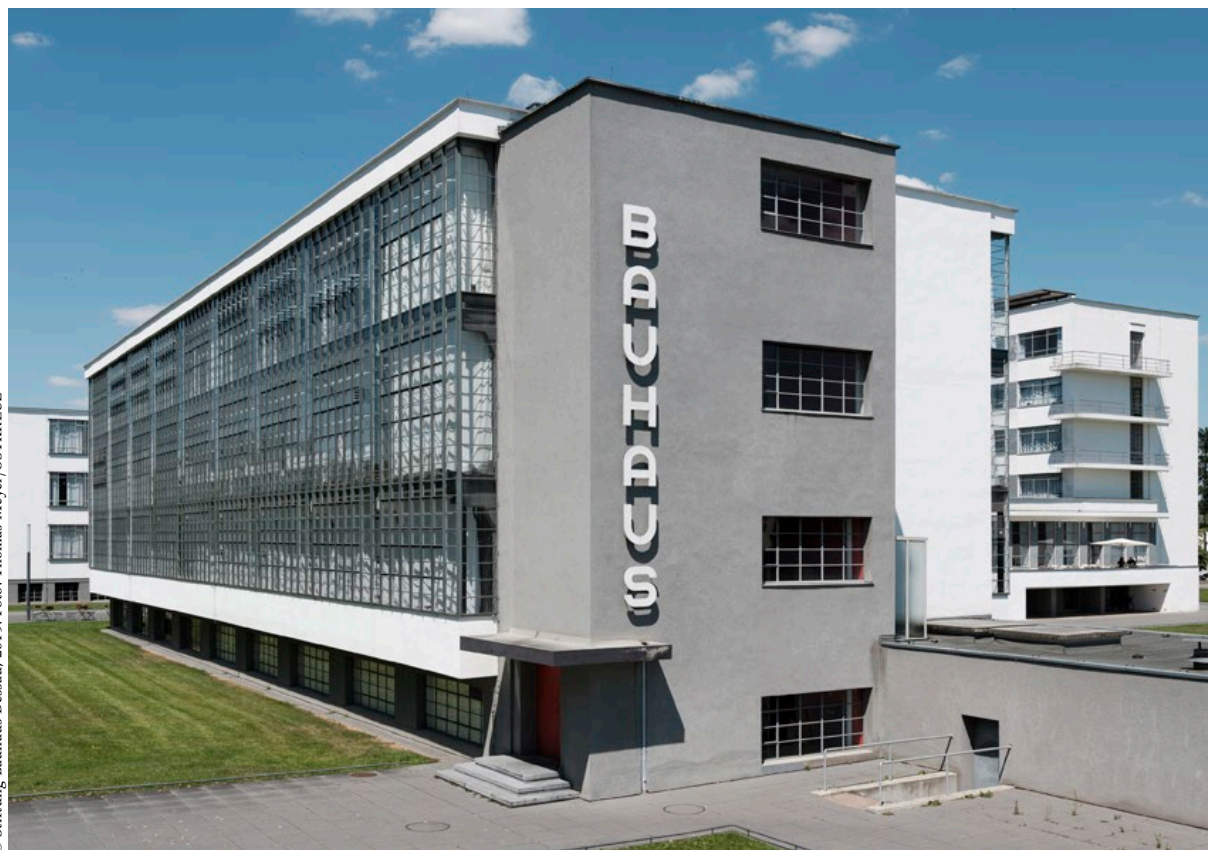
Das Bauhaus-Gebäude von Walter Gropius (1925/26), Südansicht
